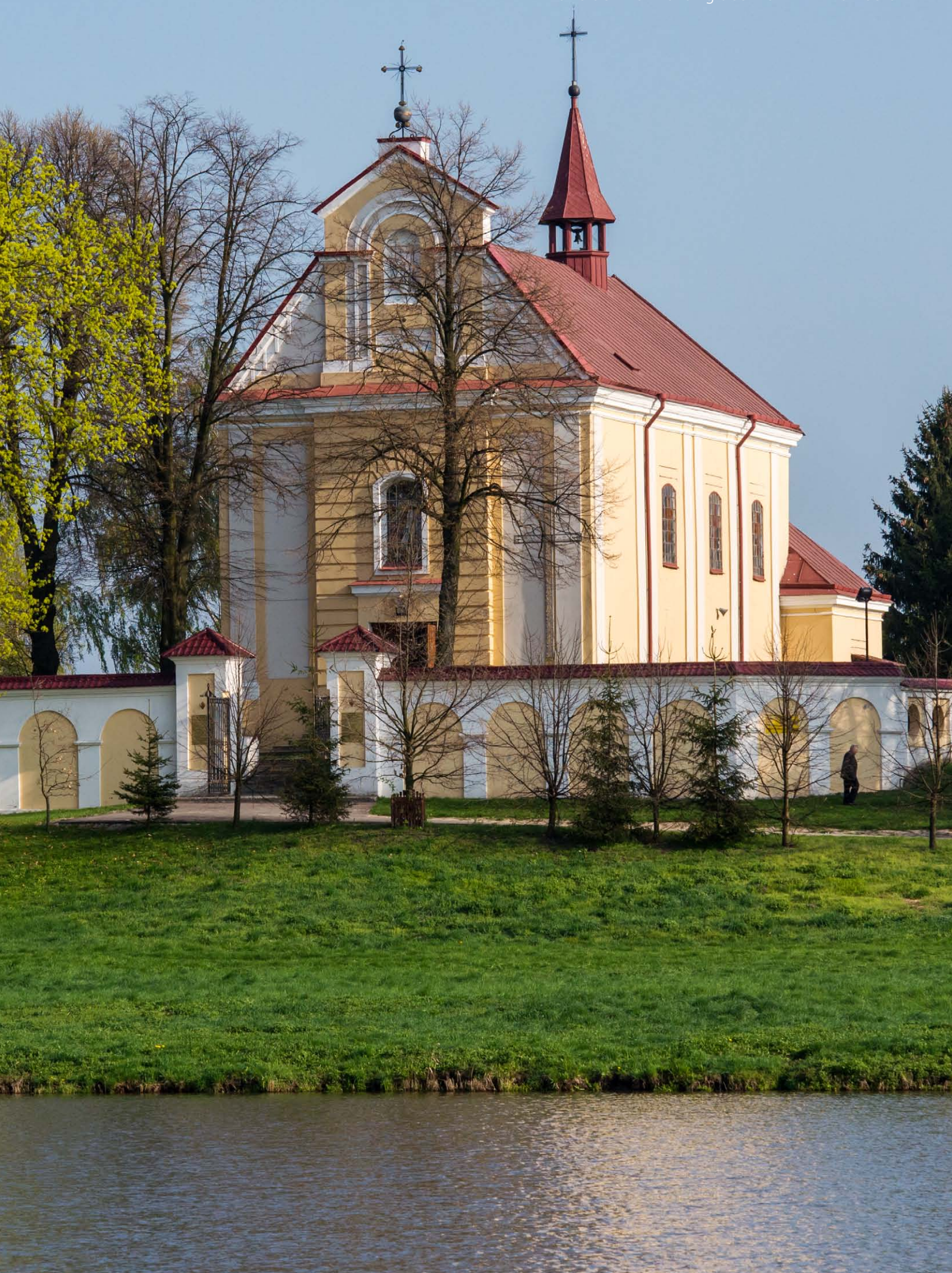
Kościół pw. Przemienienia Pańskiego w Nowosiólkach Kirche der Verklärung des Herrn in Nowosiólki
