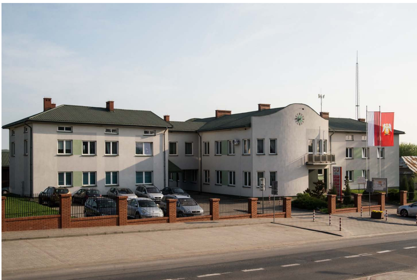
Siedziba Urzędu Gminy | Gebäude des Gemeindeamtes
